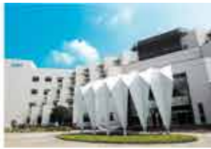
台南研發中心 (鑽石級綠建築)
