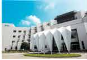
台南研發中心 (鑽石級綠建築)
